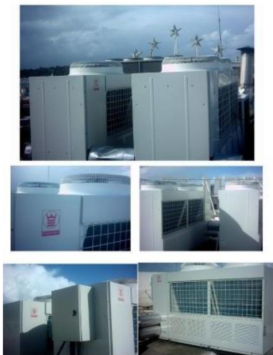
Entretien maintenance Groupe VRV (Nettoyage ventilo, contrôle étanchéité)
