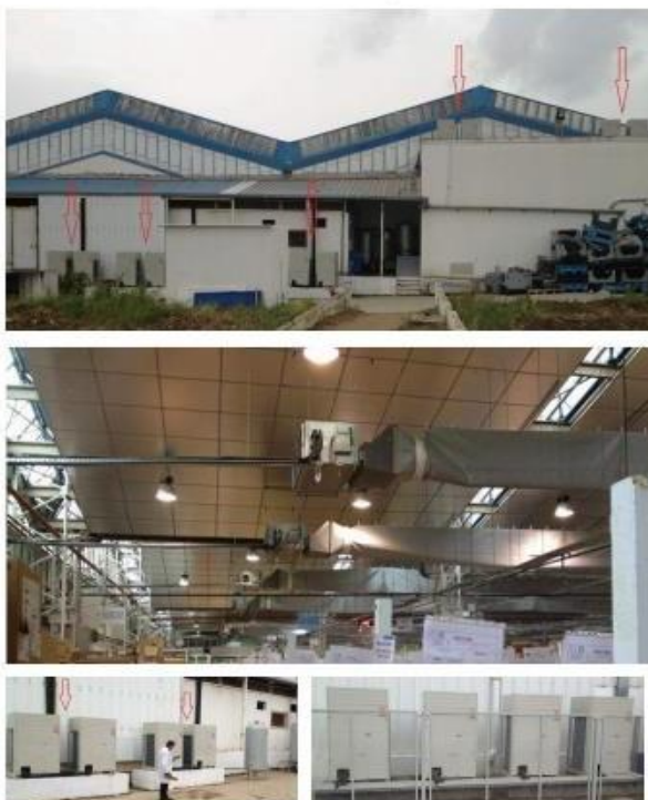
Entretien maintenance Groupe VRV (Nettoyage ventilo, contrôle étanchéité)
